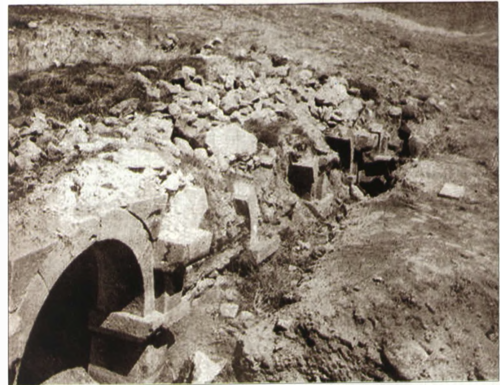
Ağkənd karvansarasının yerüstü görünüşü (XIV yüzil).
