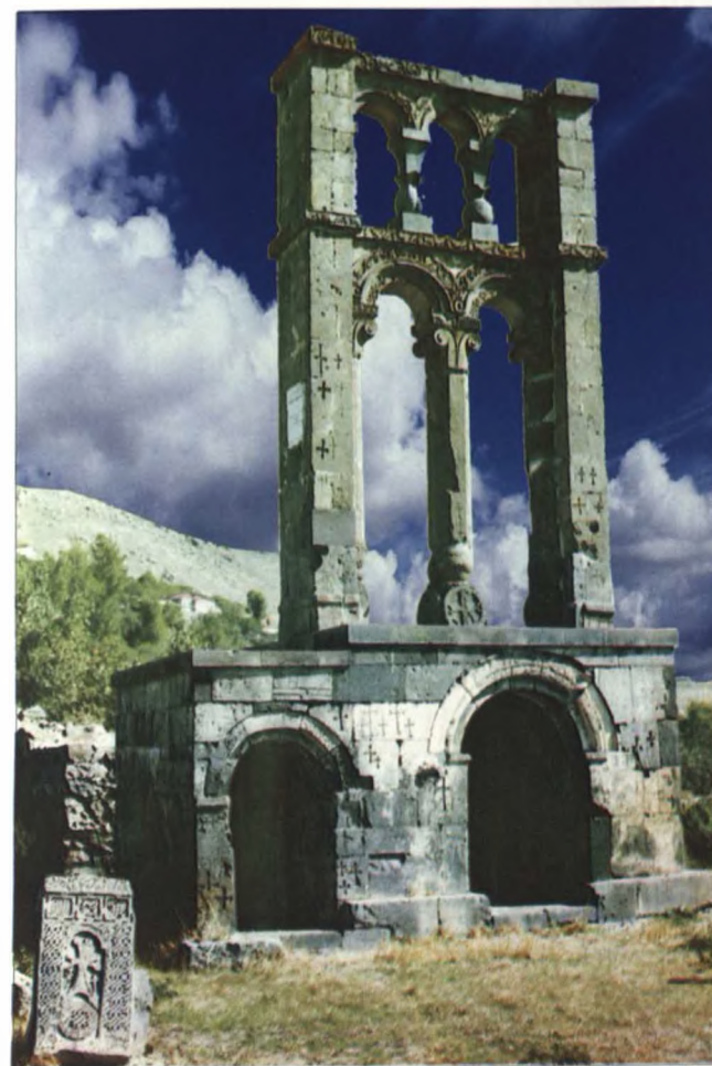
Ağudi abidəsinin bərpadan sonrakı görünüşü.
