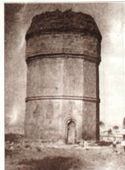
Cəfərabad//Pir Hüseyin türbəsi gümbəzi dağılmış halda.
